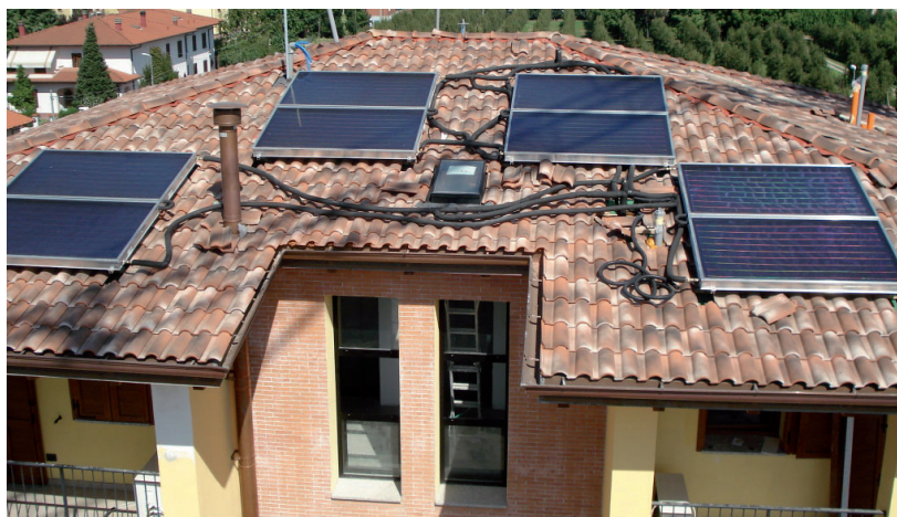
Un microimpianto da un 1 kW non è in grado di soddisfare il fabbisogno energetico di un'unità abitativa. Poiché il "minimo sindacale" è 3 kW, è ovvio che un apparato di questo genere deve essere integrato a un impianto collaborante con il Gse. Foto Vaillant
